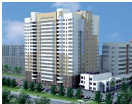
18-этажный жилой дом на ул. Татищева –Токарей
