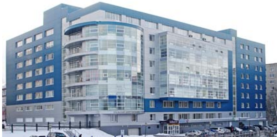
Офисное здание на ул. Коминтерна, 16
