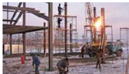
Строительство пожарного депо на 2 автомобиля
