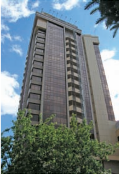
Торгово-развлекательный центр «Антей». Бестраншейная прокладка водопровода из труб ПНД с увеличением диаметра D-150 на D-300 протяженностью 250 м
