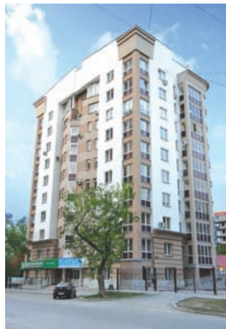
10-эт. жилой дом на ул. Хохрякова, 75
