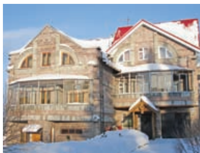
Коттеджный поселок г. Златоуст (материал стен и элементов благоустройства произведены по методу вибропрессования)
