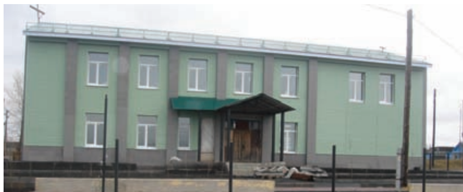
Реконструкция спального корпуса коррекционной школы в с. Озерки Красноуфимского района (ноябрь 2008 г.)
