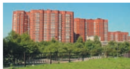
Жилой комплекс на ул. Тверитина, 34
