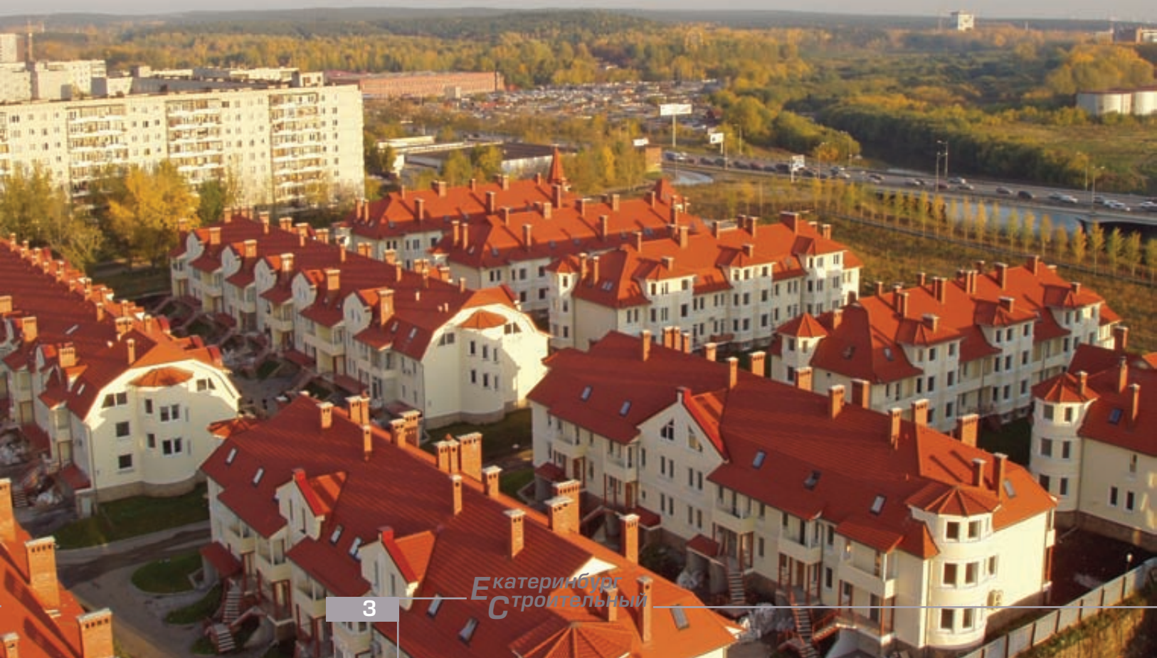
Жилой комплекс «Исеть», г. Екатеринбург
