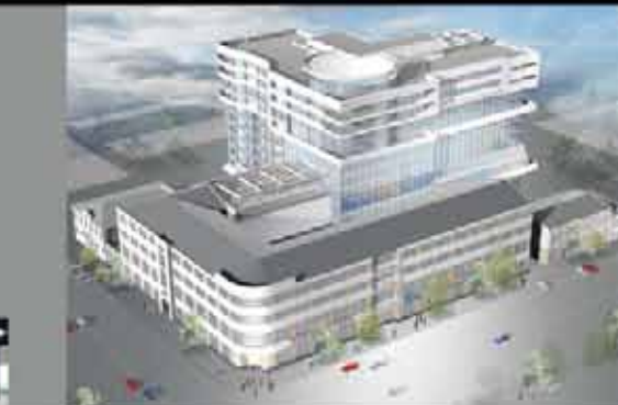
Офисное здание компании "ЭКСПО-РЕМ" на ул. 8 Марта, 12е (вторая очередь), в г. Екатеринбурге
