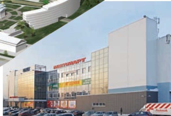
Торговый центр «Мегамарт» на ул Айвазовского, 53
