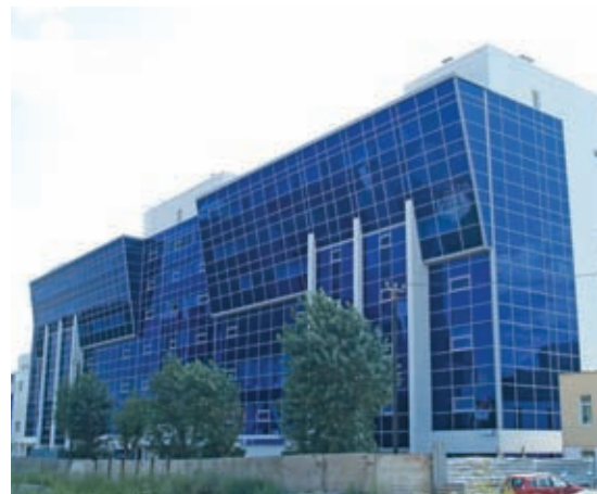
Деловой центр на ул. Чернышевского
