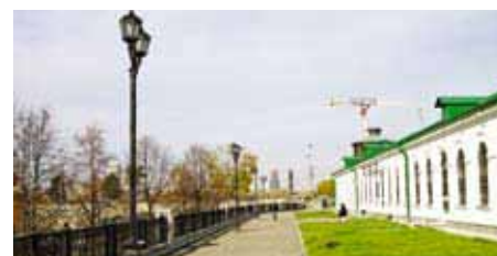
Реконструкция Исторического сквера
