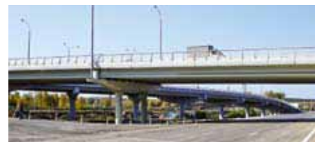
Автомобильная развязка на пересечении ул. Расточной и Серовского тракта
