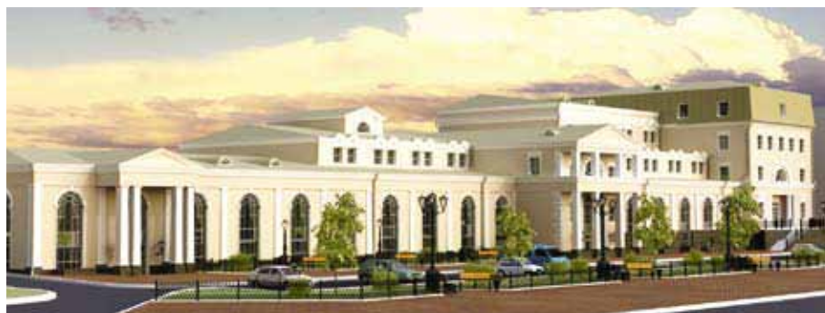
Реконструкция багажного отделения ст. Свердловск-Пассажирский
