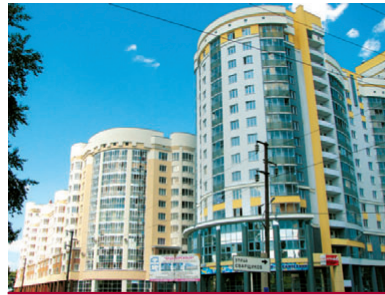
Жилой район ВИЗ Правобережный Заказчик: ЗАО АСЦ «Правобережный» Подрядчик: ЗАО «Фирма «ВИЗСТРОЙ» ЗАО «Аранта +» ООО СК «Гранд-Строй» Проектная организация: ОАО «Уралгражданпроект»
