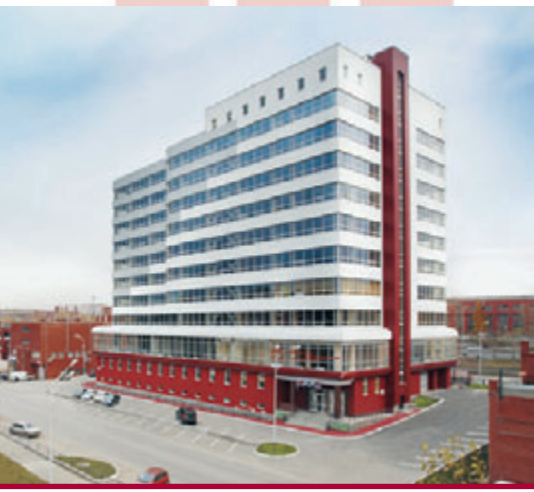
Административное здание на ул. Крестинского Застройщик: НП «Уралэнергостройкомплекс»
